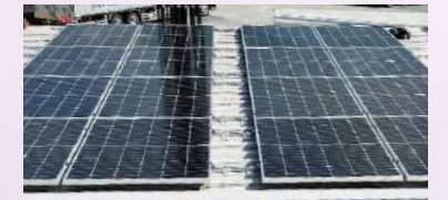
太陽光パネルの設置
