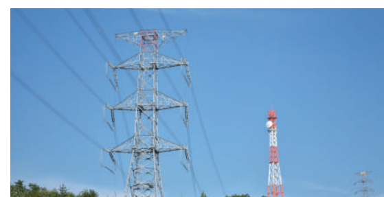
送電設備の一部を活用した災害に強い光中継網
